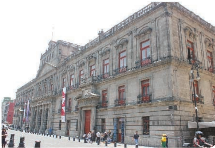
Figura 3.27 Edificio del Real Seminario de Minería fundado en 1792, hoy Palacio de Minería en la Ciudad de México.
