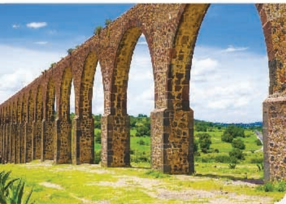
Figura 3.44 El magnífico acueducto novohispano del padre Tembleque, patrimonio de la humanidad, por el que se surtía de agua a la población de Otumba, Estado de México, y pueblos aledaños.
